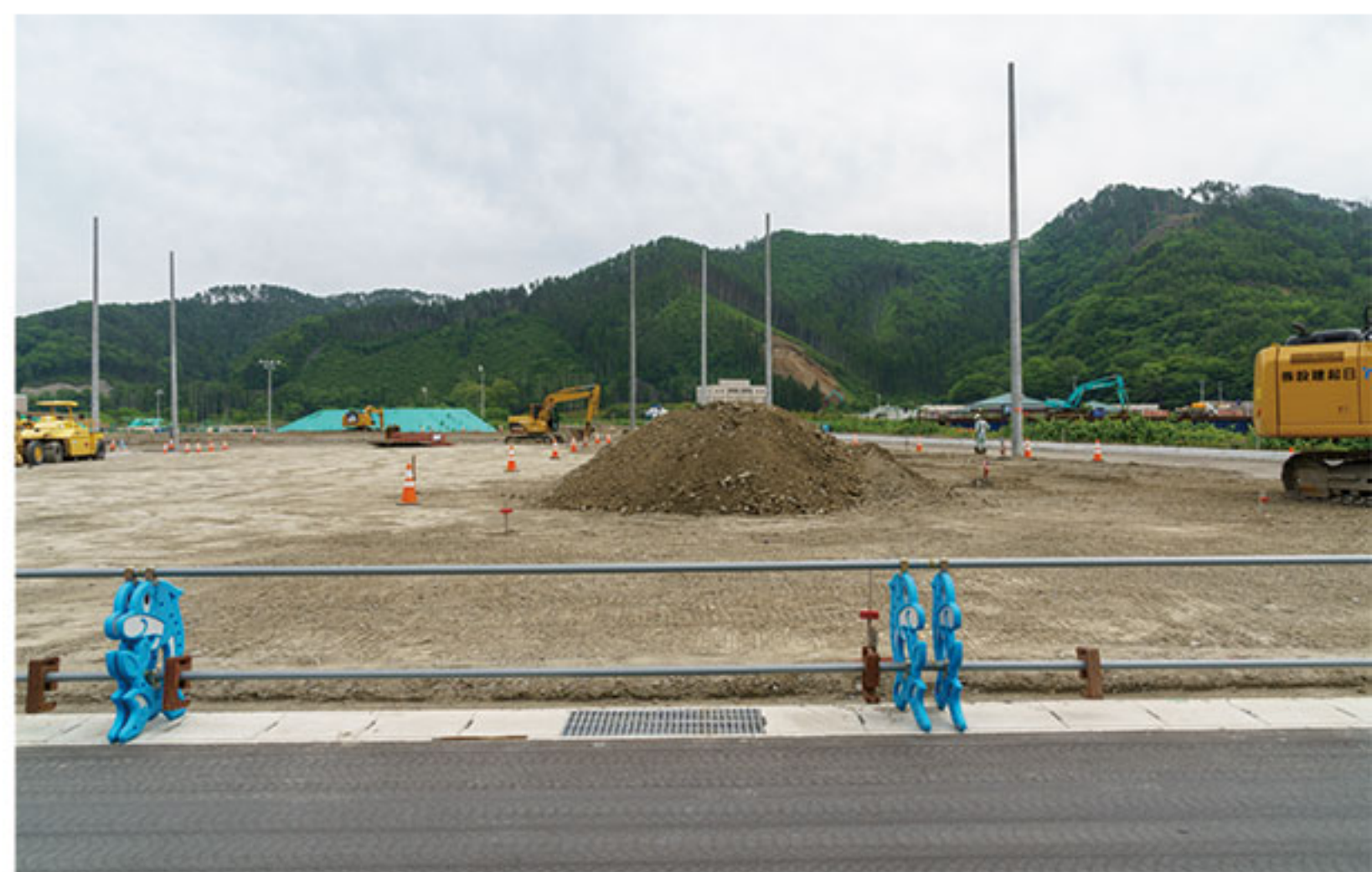
6月7日：上の写真で削り取った土が集められている。
