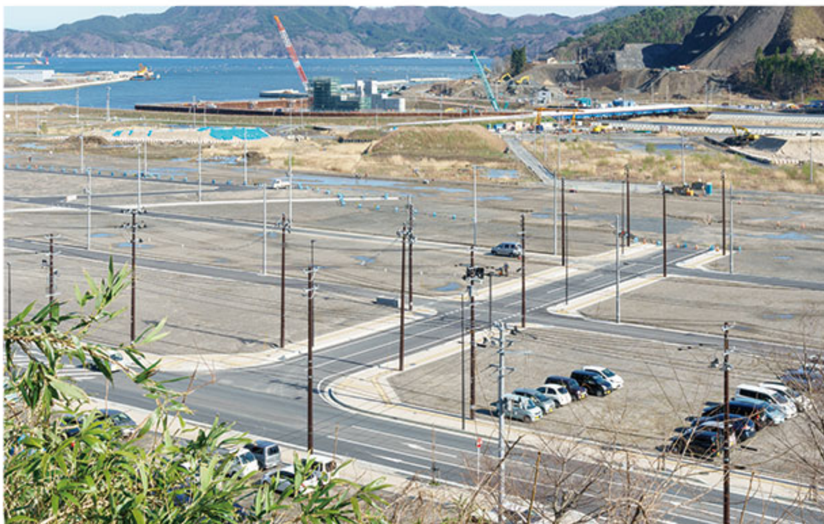
4月18日：県道145号（大槌停車場線）を高台から。写真の範囲では住宅再建はまだ始まっていない。
