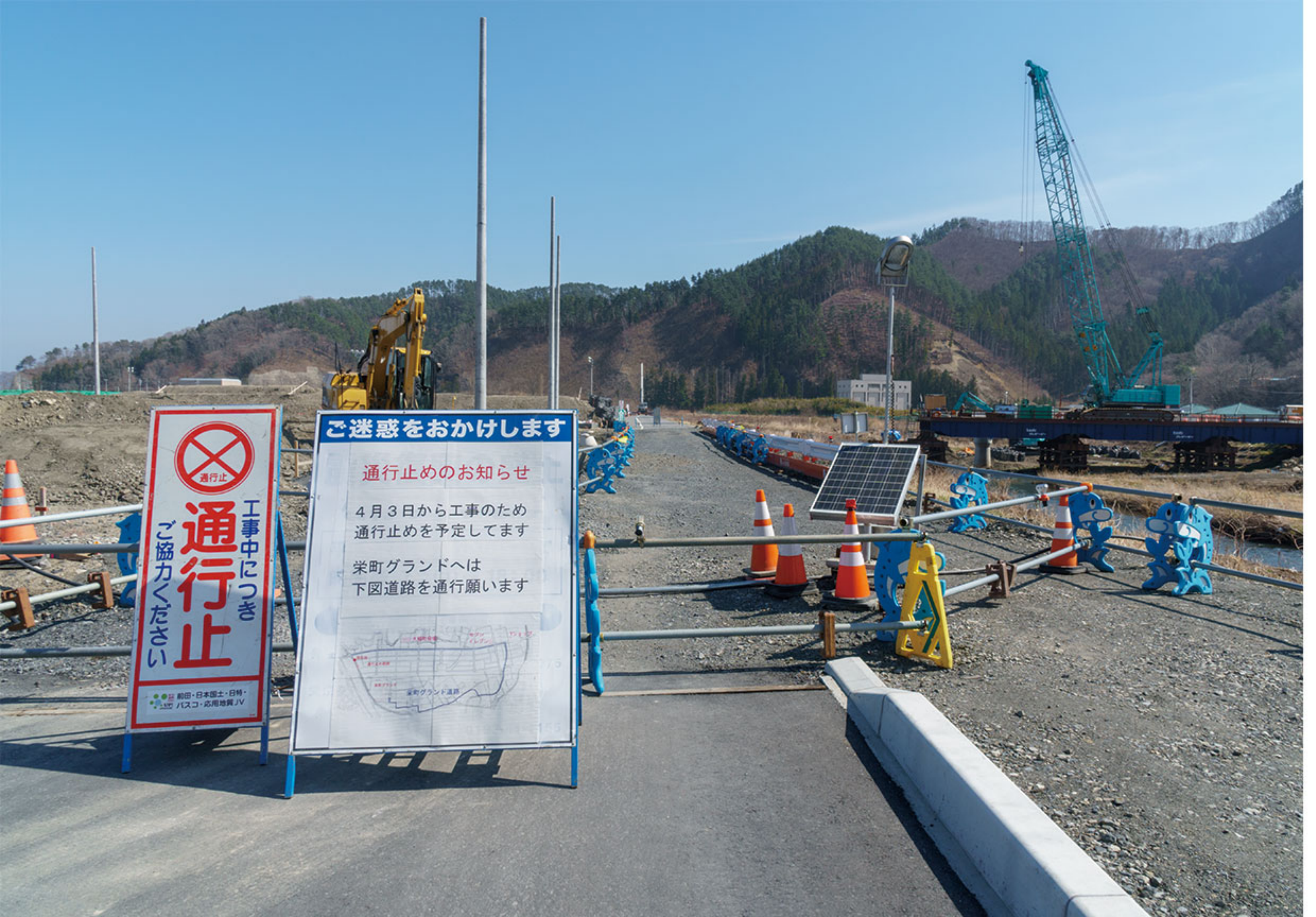
4月6日：古廟橋交差点から南へ1ブロック進んだ小鍬川沿いの街区。4月2日まではここを直進することで栄町グランドへ行くことができたが、宅地整備のため封鎖され、かなりの遠回りを強いられることになった。宅地整備が進んでいる証左である。
