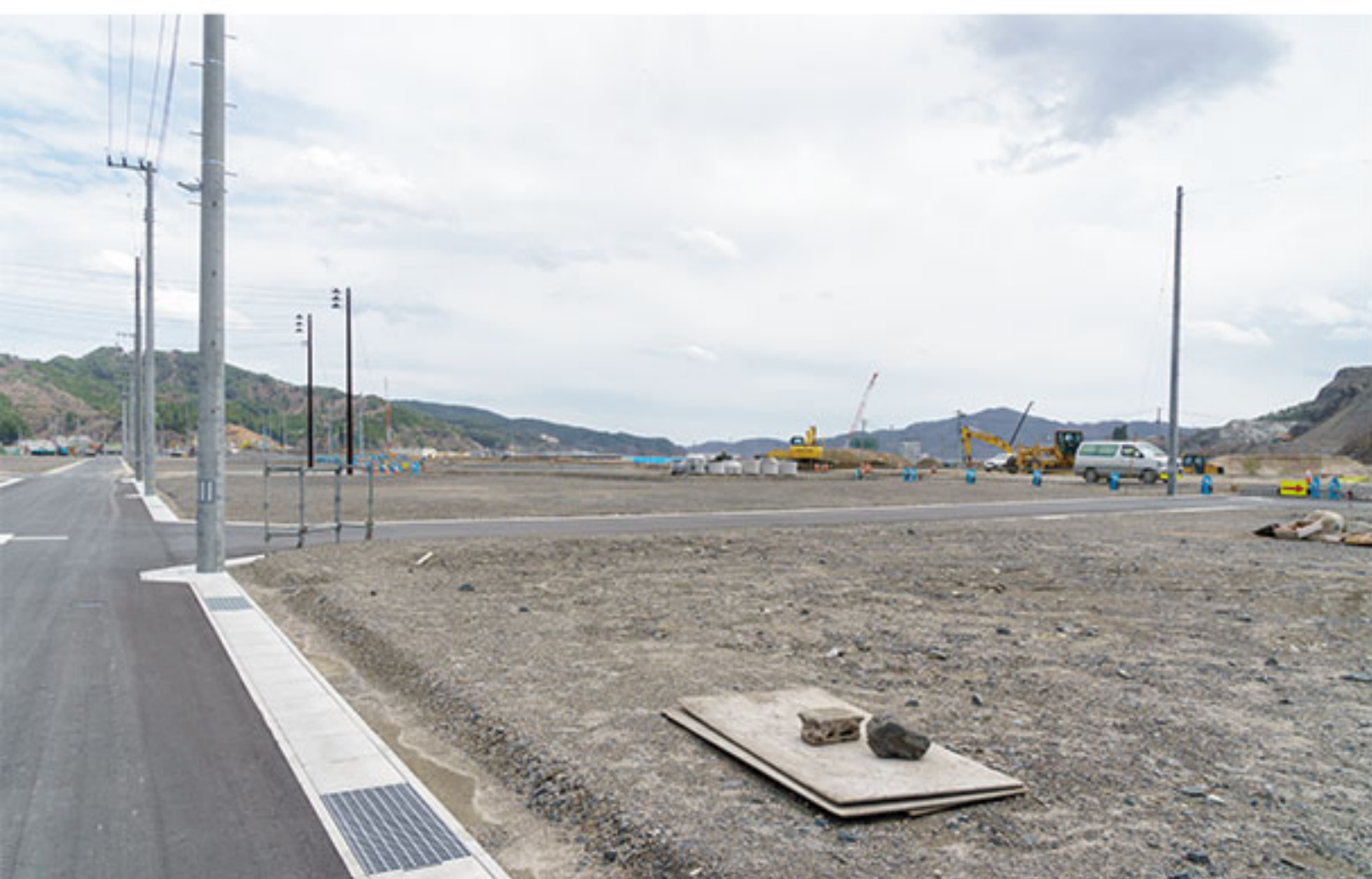
4月19日：本町、大町のほとんどは3月1日までに宅地引き渡しが行われており、工事を行っているのは最南端の街区のみとなっている。
