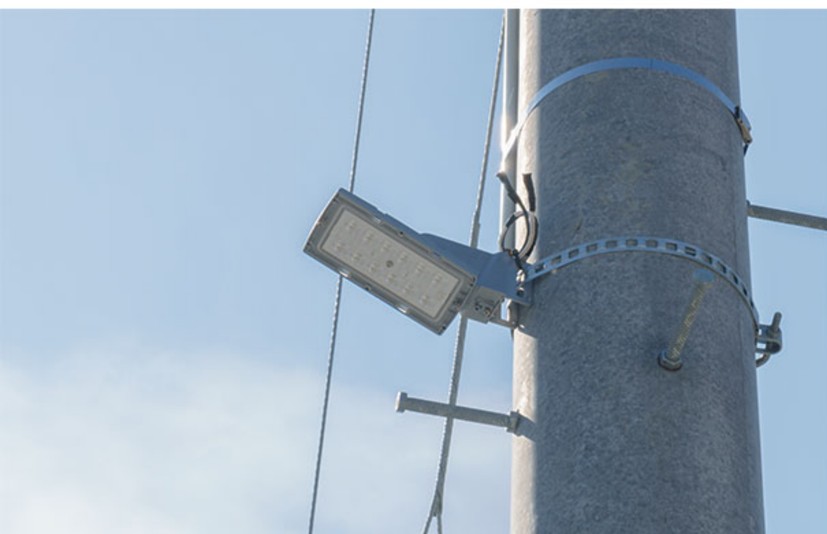
4月6日：電柱に設置された街路灯。ランプの種類はLEDである。
