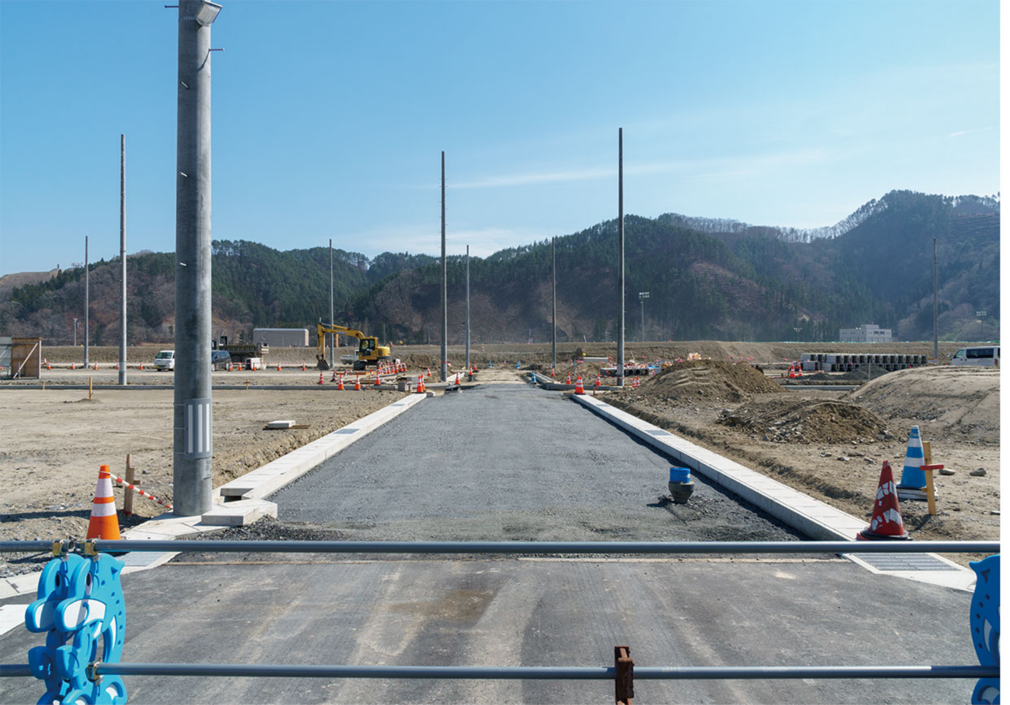
4月6日：県道から1ブロック南側の街区（南北方向）の様子。右の写真より東側の街区である。こちらはU字溝の設置も終わり、路盤の工事まで終わっていると思われる。この上からアスファルトによる舗装を施すと道路として完成する。電柱は設置されているが電線は架線されていない。
