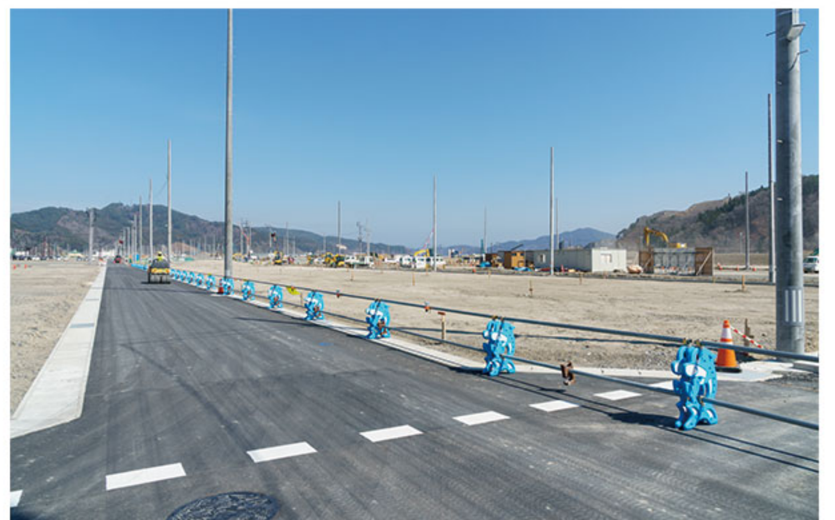
4月6日：県道から1ブロック南側の街区（東西方向）の様子。右の写真で紹介した街区より東よりの街区である。工事の進捗状況から、東側から整備を進めていることが分かる。
