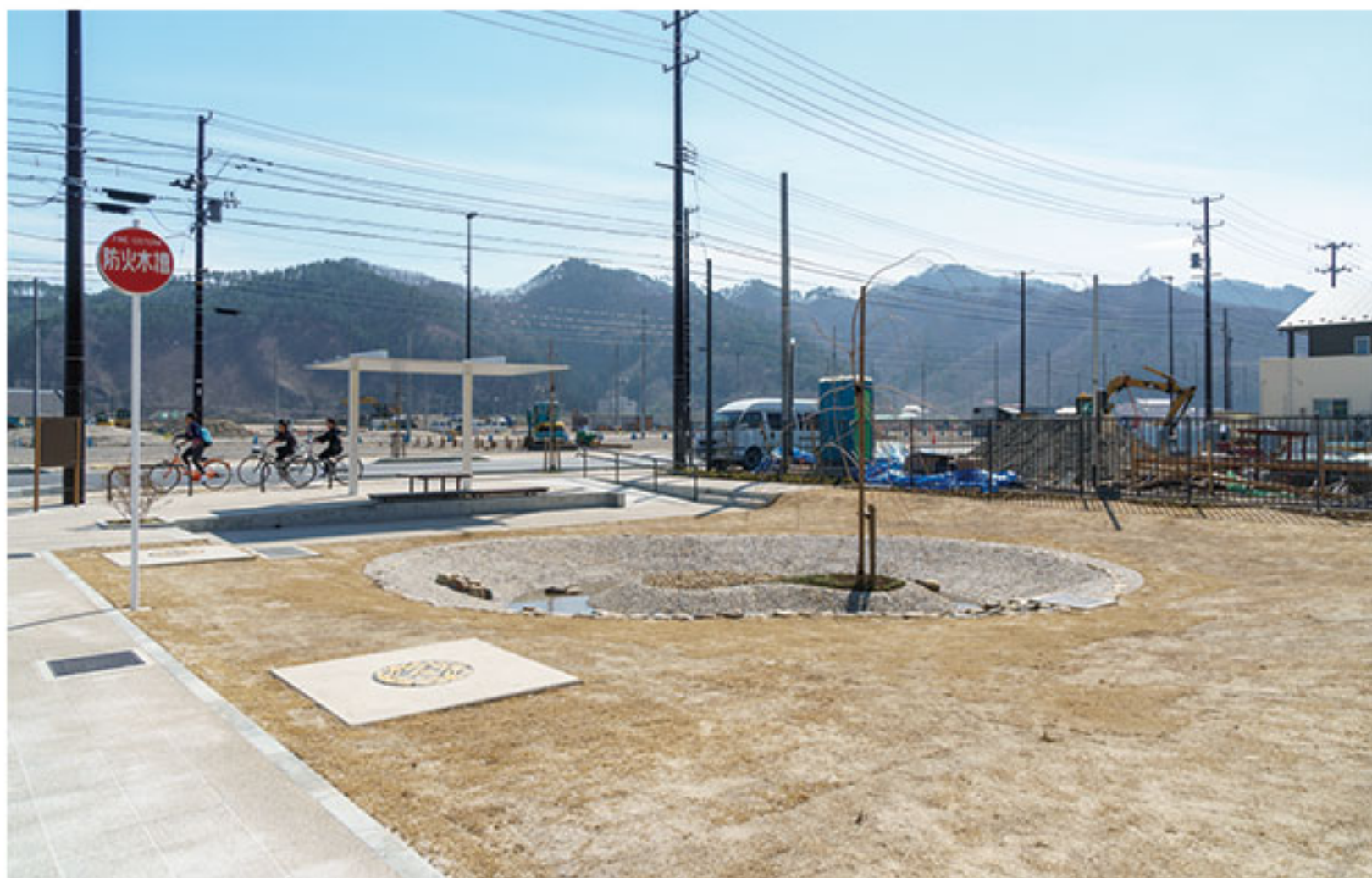
4月6日：区画整理事業によって整備された公園のうちいくつかには防火水槽が設置されているが、代官所跡公園はそのうちの一つ。
