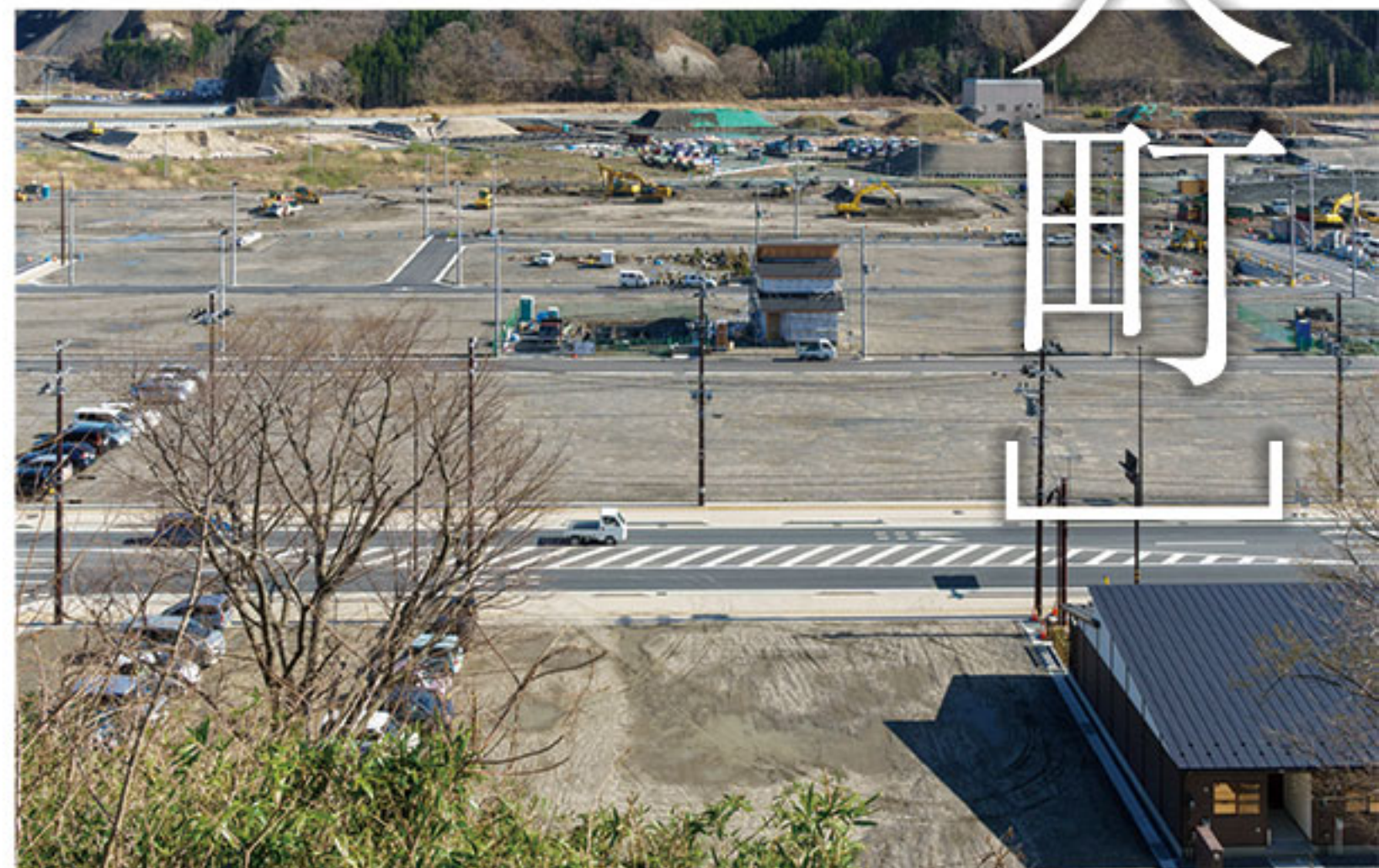
4月18日：本町を高台から。奥の方で住宅再建が始まっている。右下の住宅は災害公営住宅。
