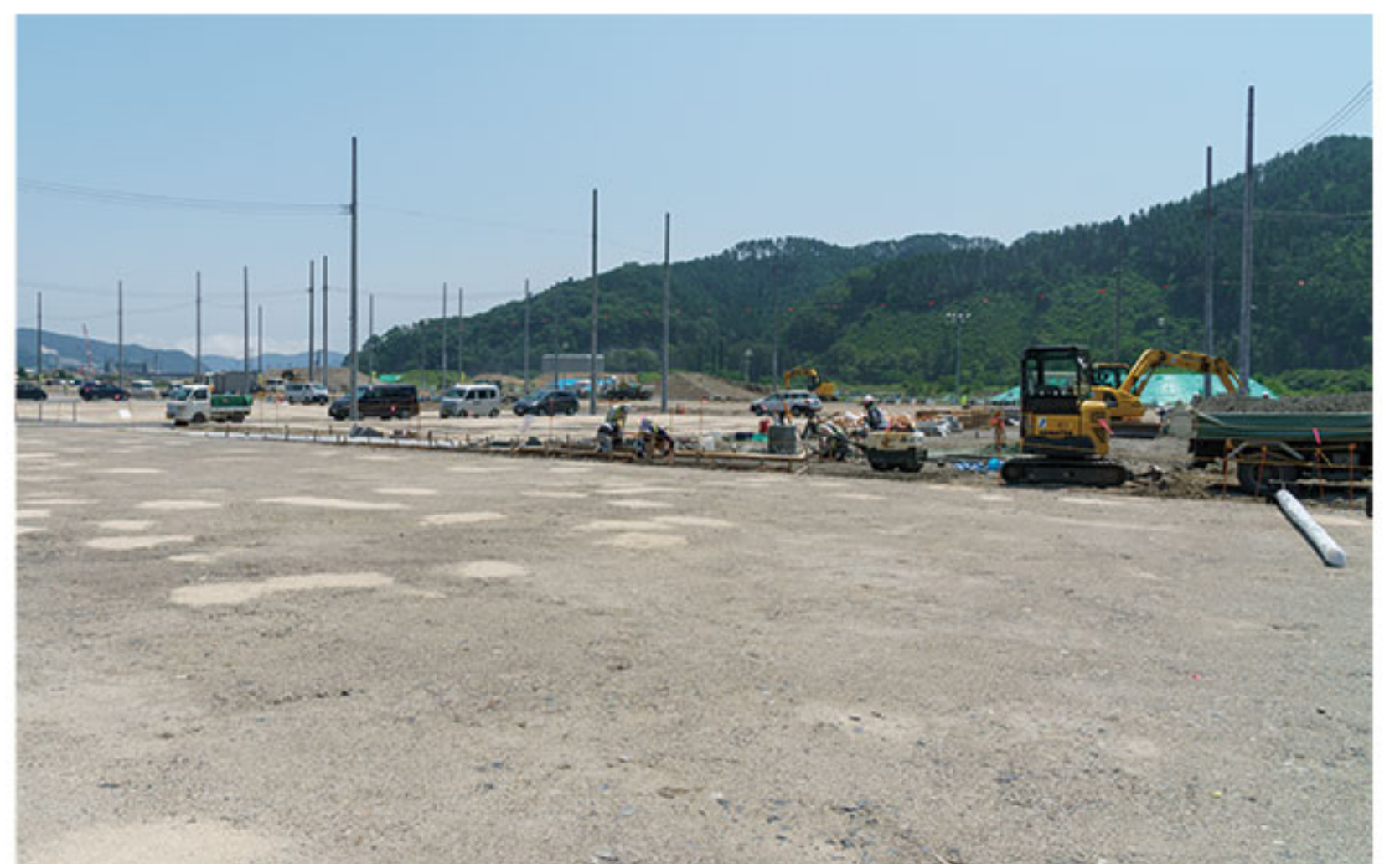
7月21日：公園（城内公園）の整備の様子をアップで。城内公園にはかつての街並みを彷彿させる井戸が設置される。町方地区には自噴井戸やポンプアップによる井戸が多数あったが、 ←続く
