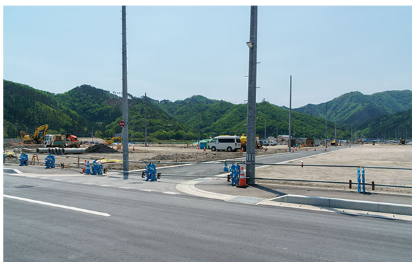
5月20日：右側の街区（北側）の宅盤はほぼ完成し、左側（南側）の街区の整備を行っている。
