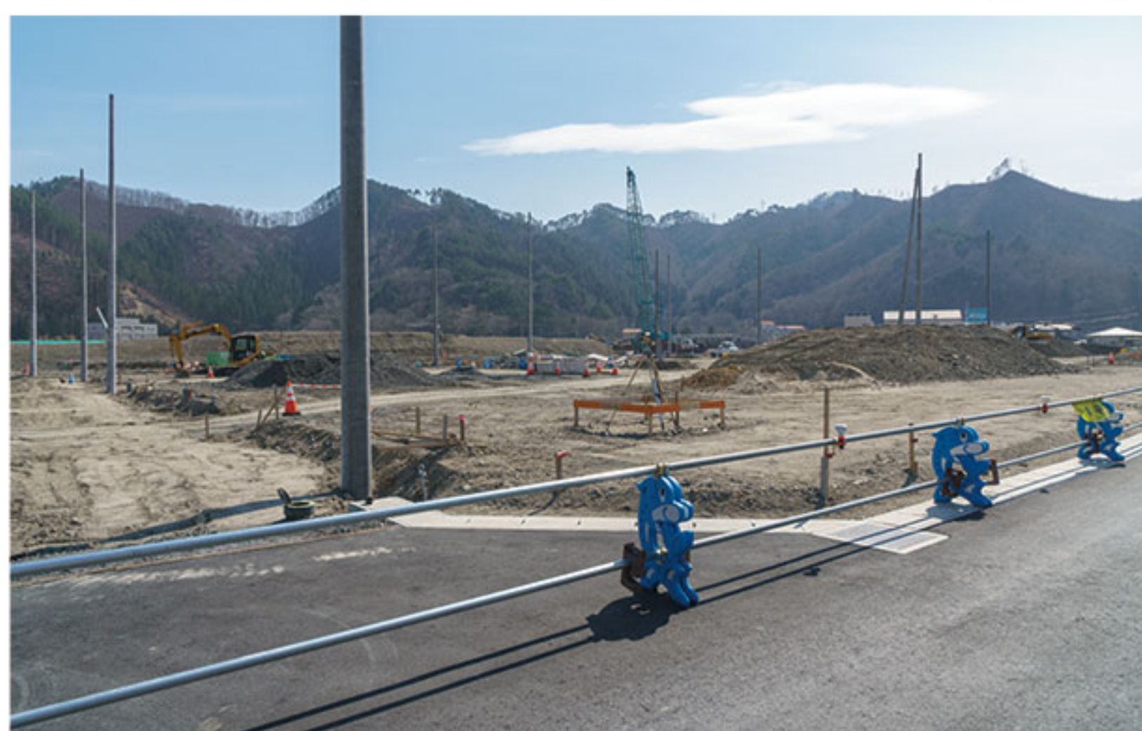
4月6日：県道から1ブロック南側の街区の様子。工事が設計通り進んでいるか確認するため、測量するための機材が設置されている。
