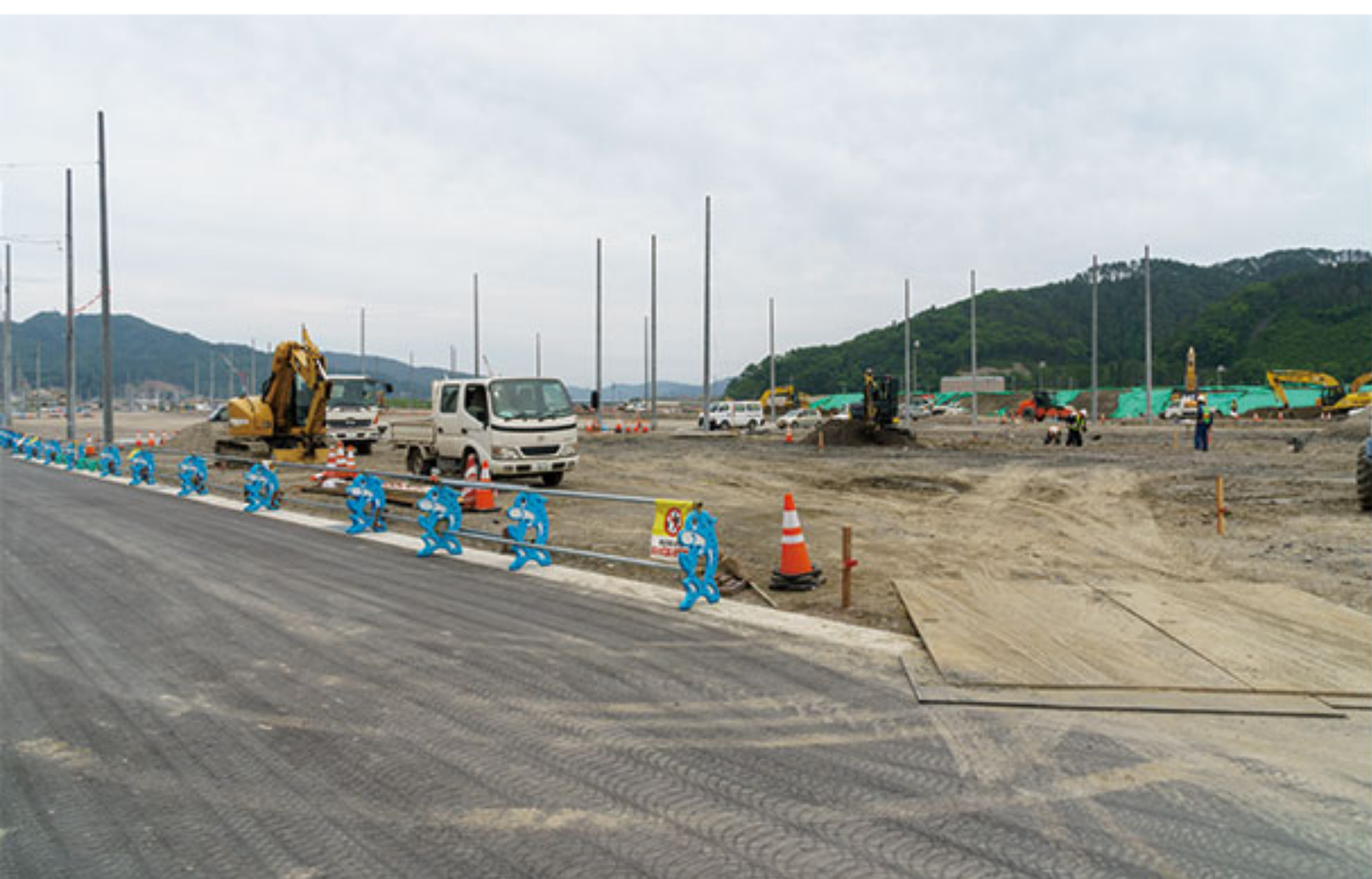
6月7日：計画高さを目標に土を削っている。U字溝の設置が終わっているため、出入りをする場所には鉄板を敷いてU字溝を保護している。
