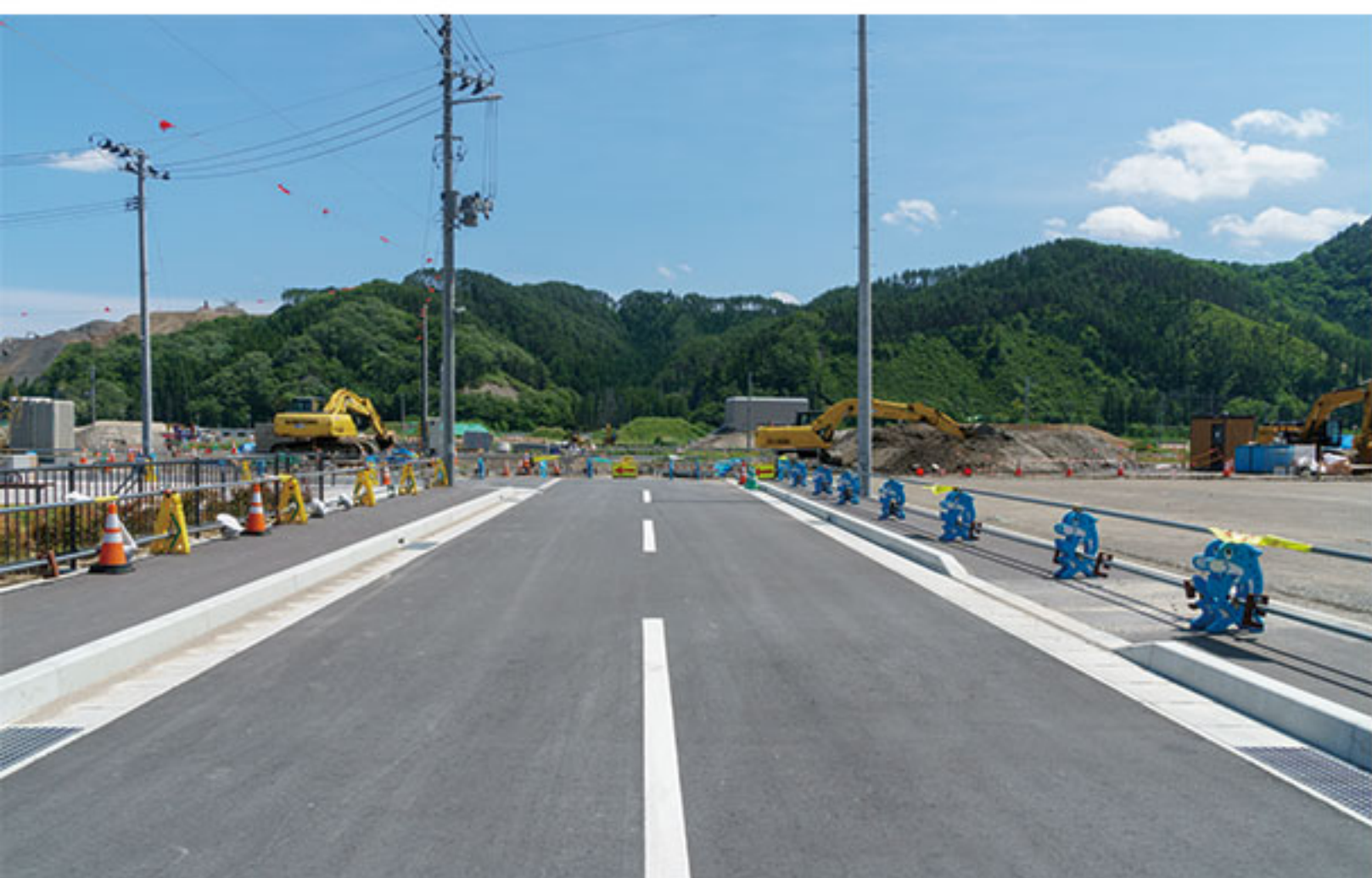
6月22日：本町と上町の境目の道路から。左側が本町、右側が上町。
