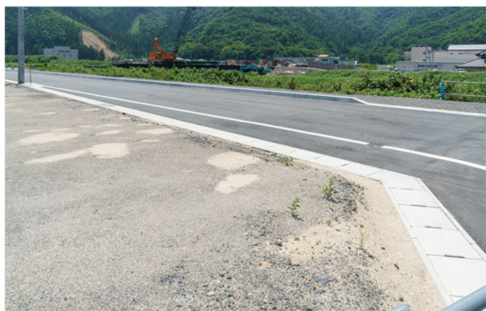
7月21日：小鎚川沿いの街区。宅地整備が終わっている。
