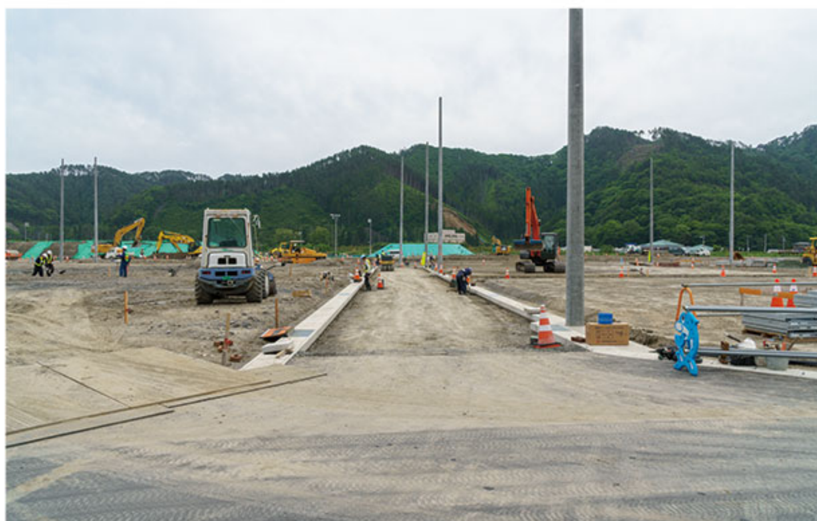
6月7日：U字溝の隙間に土を押し込み、舗装の準備をしていると思われる。
