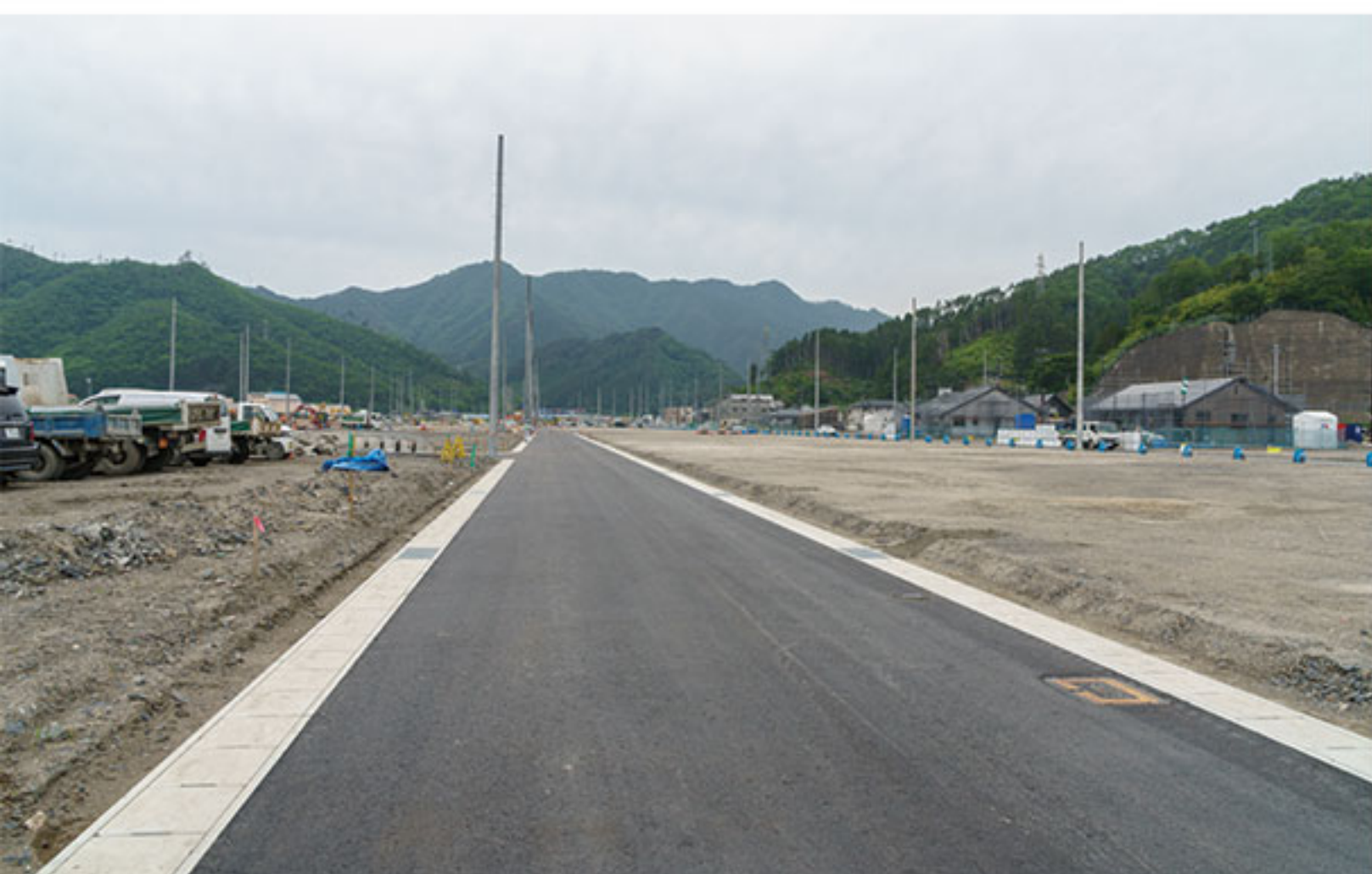
6月7日：東西方向の道路。舗装まで終わっている。
