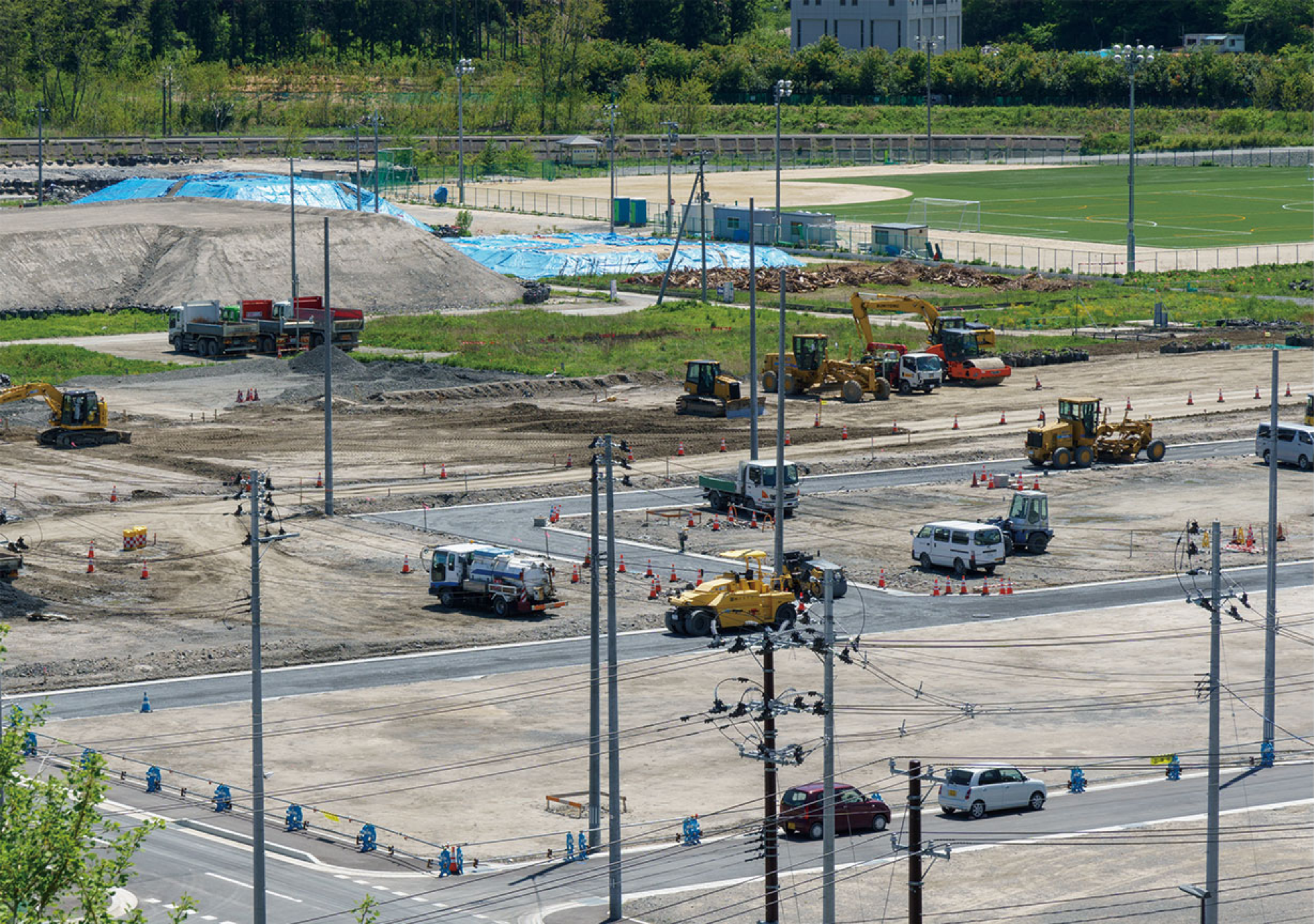
5月17日：右の写真の続き。表層（アスファルト）を舗装する準備を行っている。さらに奥の街区では余盛りの撤去が終わっている。 ※盛り土造成は、計画高さの土+二階建て木造住宅に相当する重さ（ 30\text{kN/m}^2 \approx 3\text{t/m}^2 ）の土（余盛り）+沈下量相当の土（余盛り）を盛り、地盤を締め固め、地盤の沈下が収まったら余盛りを撤去し、計画高さに仕上げている。これにより住宅再建の地盤沈下を防いでいる。
