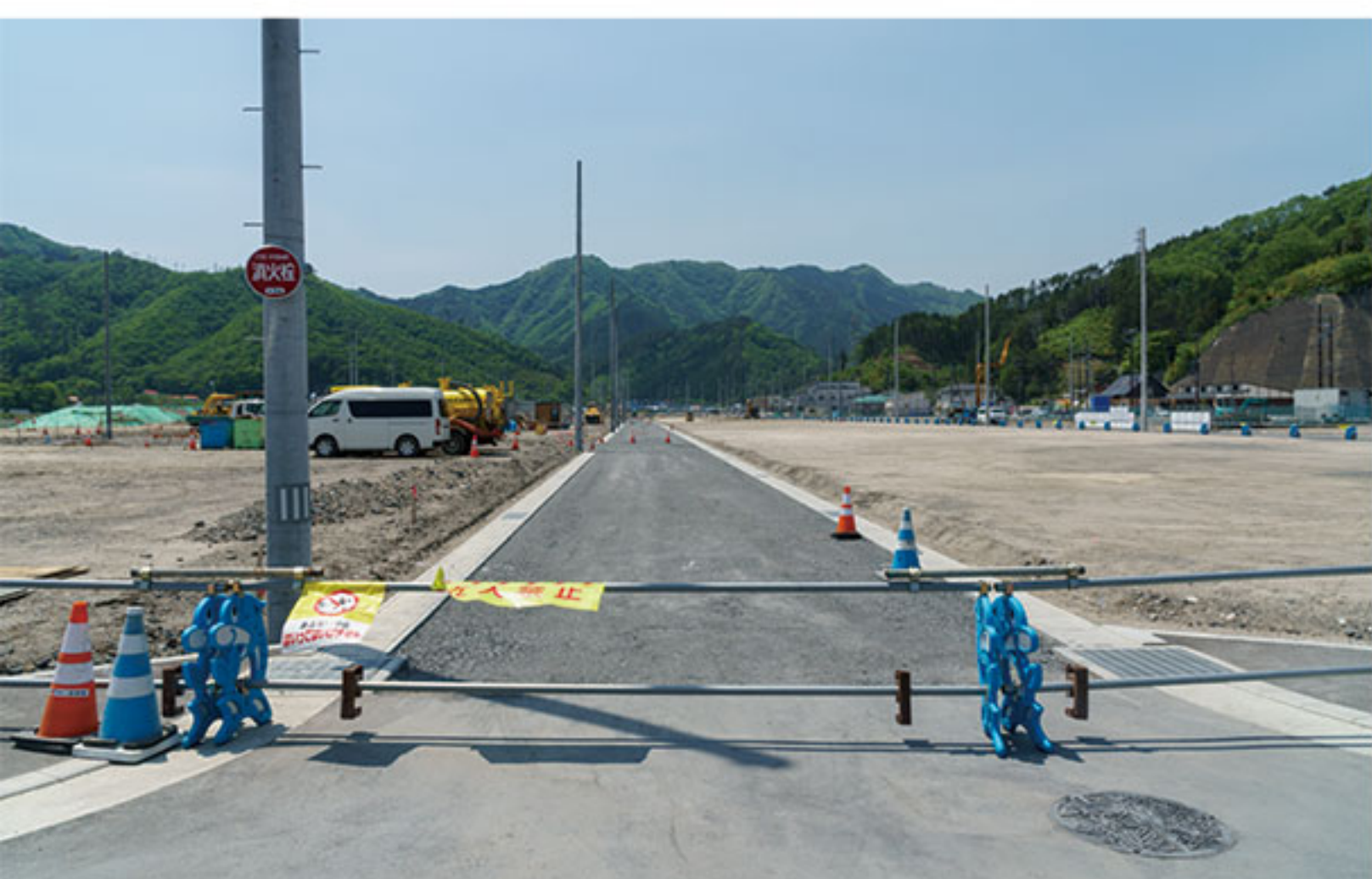
5月20日：東西方向の道路。基層の準備が終わり、表層（アスファルト）の舗装を待つだけとなった。
