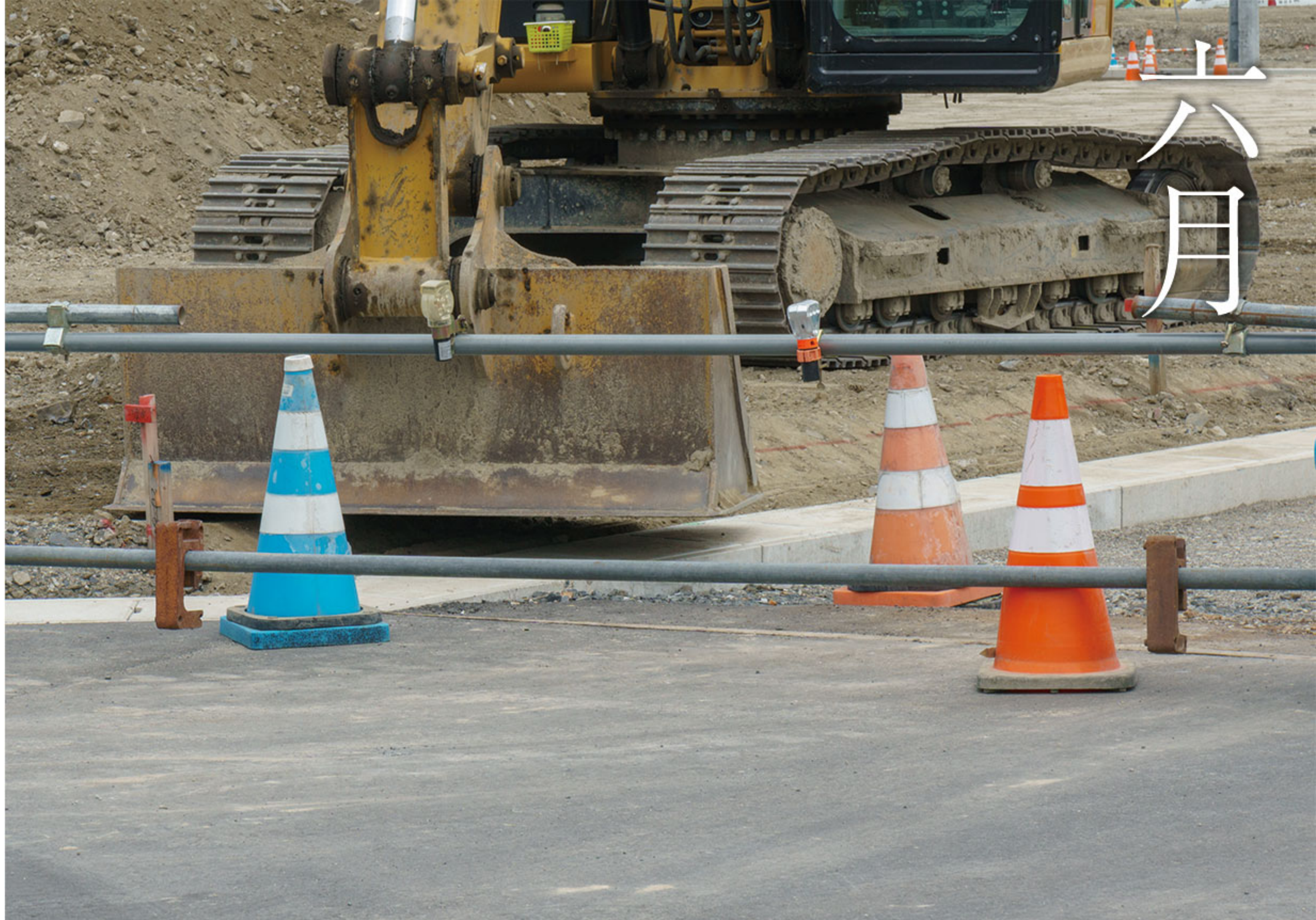
6月7日：宅盤の計画高さに沿って赤い線が引かれ、その線を目標に土を削っている。宅地整備も最終段階のようだ。
