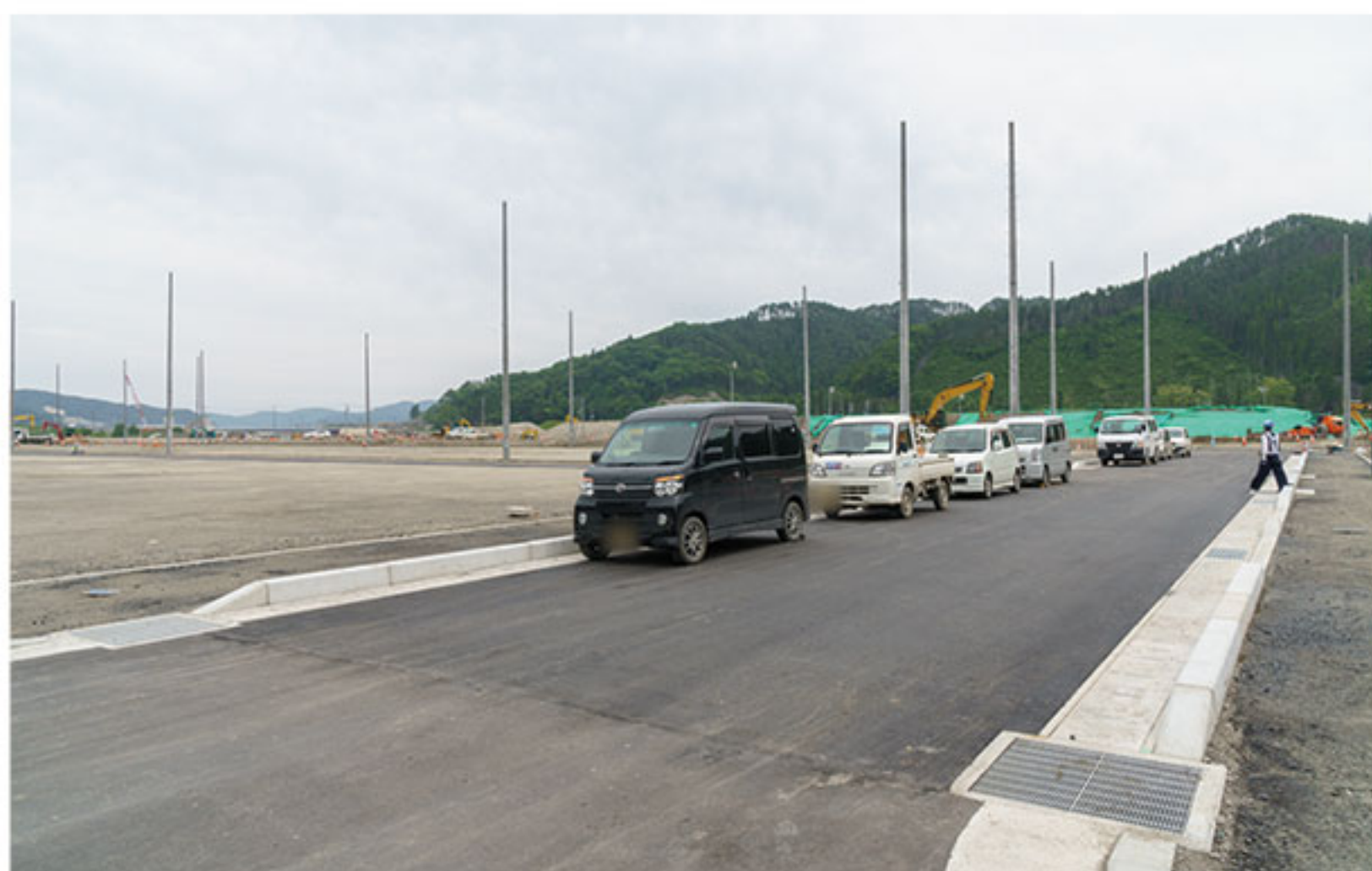
6月7日：小鎚神社から南側の道路。道路の舗装は終わり、歩道部分の舗装を残すのみとなった。
