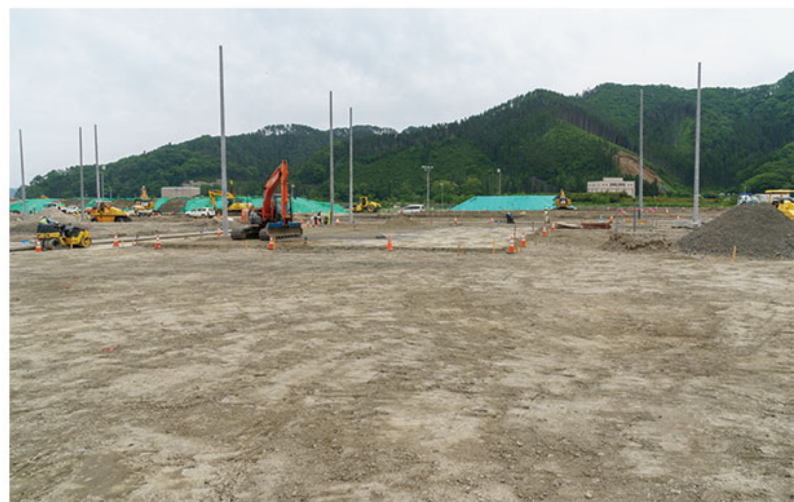
6月7日：表面の土を削り取り、目標の高さに仕上げている最中。
