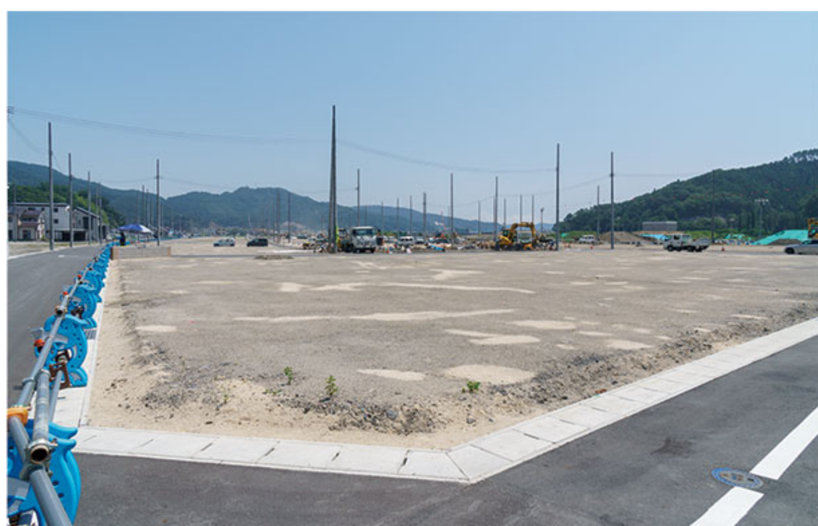
7月21日：小鎚川沿いの街区。奥の方では公園（城内公園）の整備が行われている。
