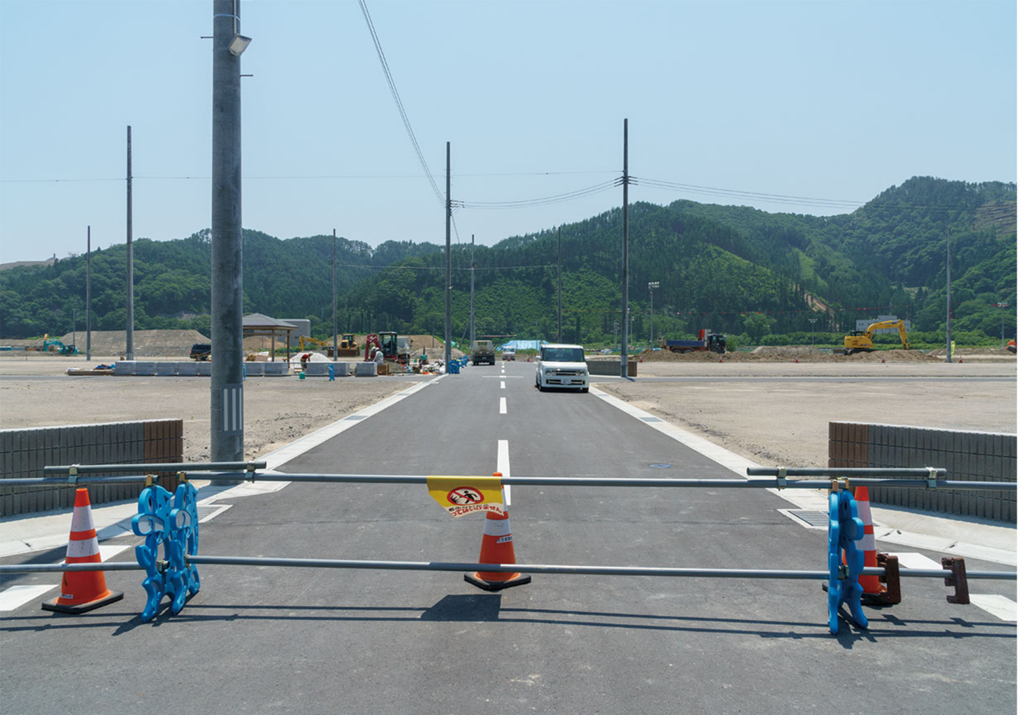
7月21日：電線の架線が完了している。手前の左右にあるブロック塀はゴミ捨て用のカゴを設置するスペース。奥の方で工事を行っている公園は四日町公園。町方地区内の公園の名称は古くに用いられた町名を基に設定されている。四日町は、大槌代官所が設置される前、まだ大槌城代がいた1617年頃、南部藩主が八日町（毎月八日に市を開いた）だけでは足りないという理由で四日にも市を開くように命じたことで誕生した。
