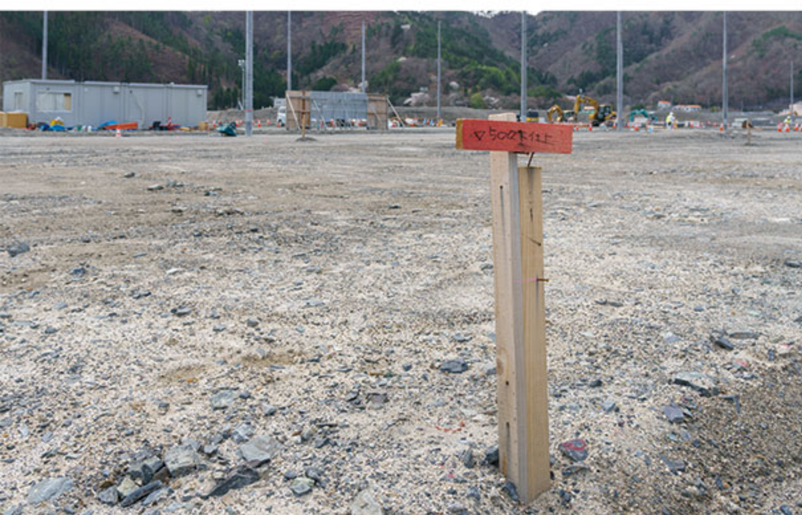
4月19日：「▽500下仕上」という表記から、この目印から500mm下が宅盤の目標高さであることが分かる。
