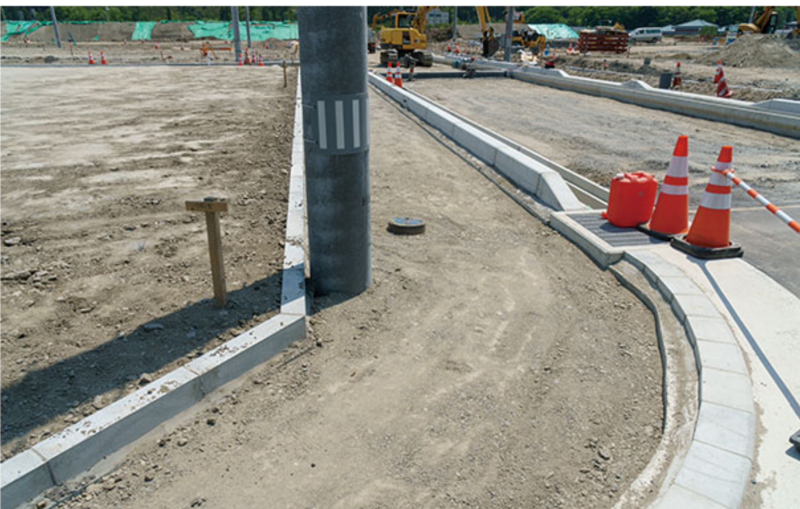
5月20日：右の写真の交差点部をアップで。歩道が設けられた道路のため、電柱や水道管は歩道に配置されている。
