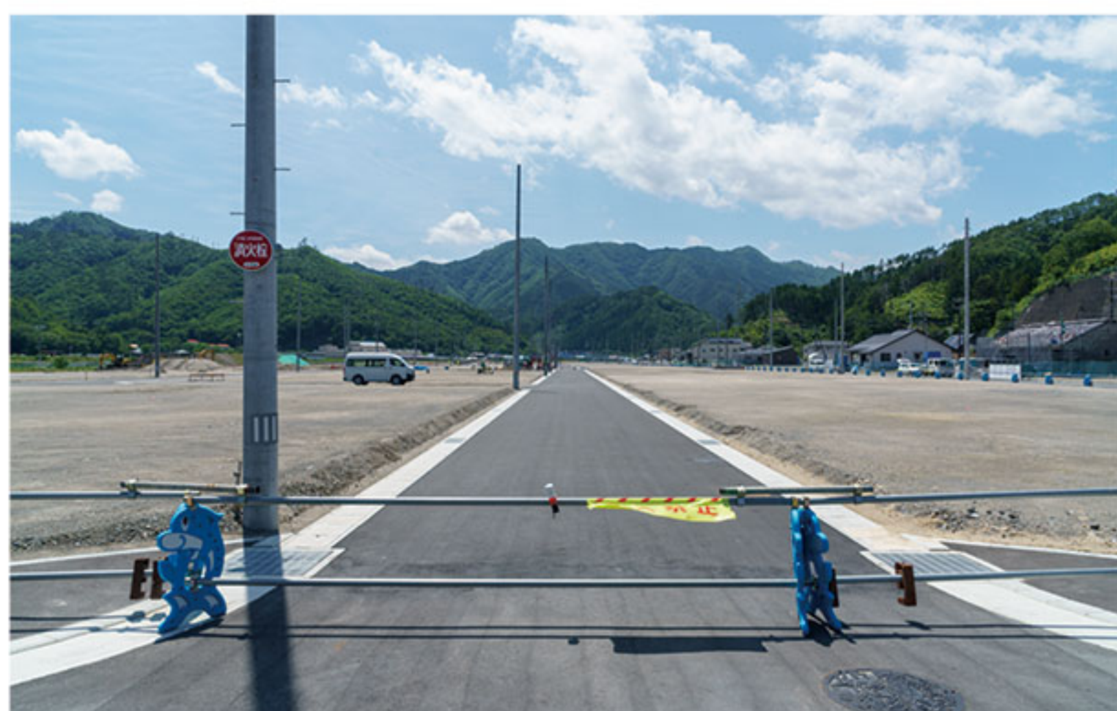
6月22日：左の写真の右側。県道から南に2街区目と3街区目の間の道路。舗装が終わっている。電線の架設はこれから行われる。
