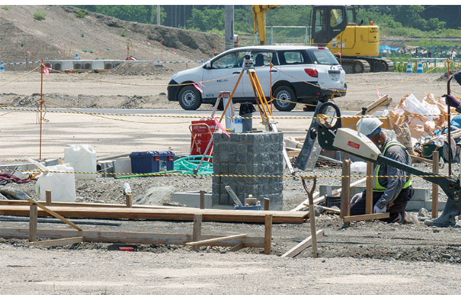
続き→ 盛り土に影響を与えたり、盛り土により井戸のパイプが破損する恐れがあることから、祈禱の上、一部を残し全て閉塞された。この城内公園には数少ない保存された井戸が設置される。
