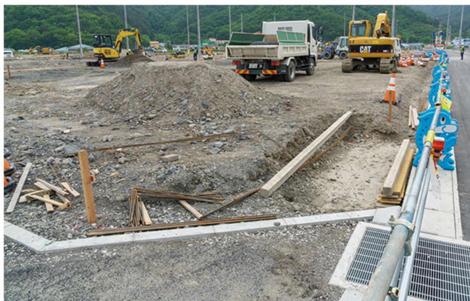
6月7日：隅切り部分の工事の様子。
