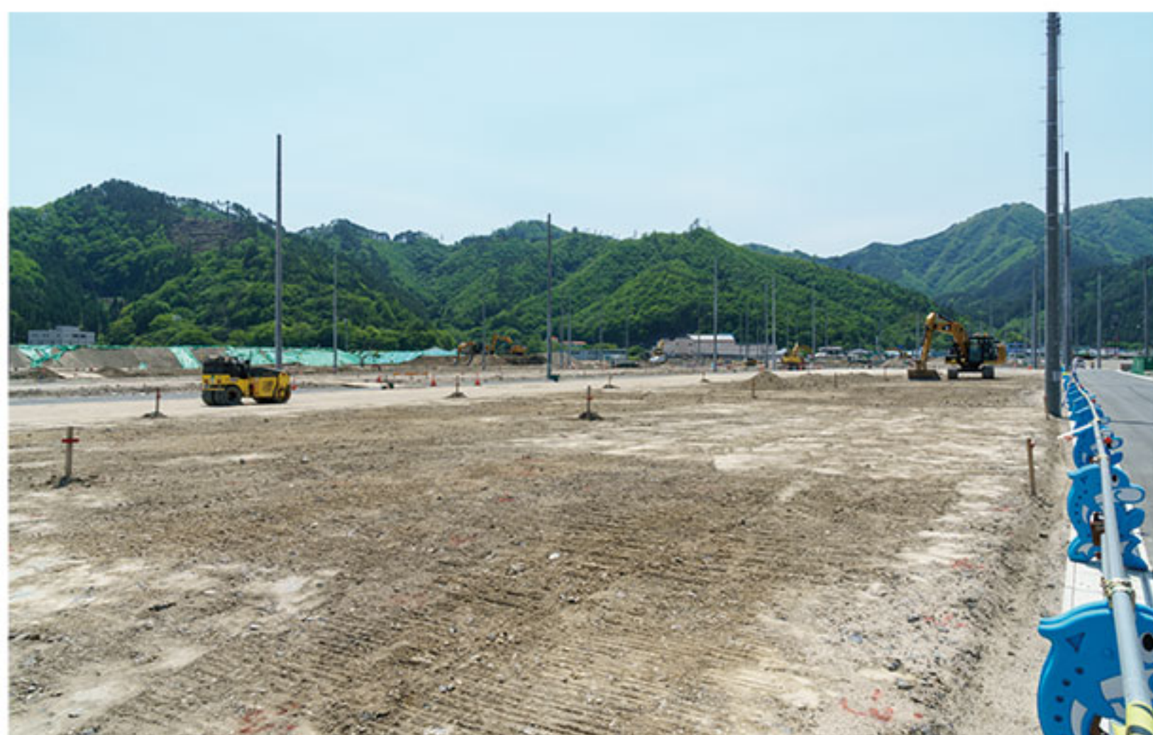
5月20日：宅盤の整備が進んでいる。盛り土は真砂土と岩ずりのブレンドで行われ、 30\text{kN/m}^2 の基準値を目標に施工されている。
