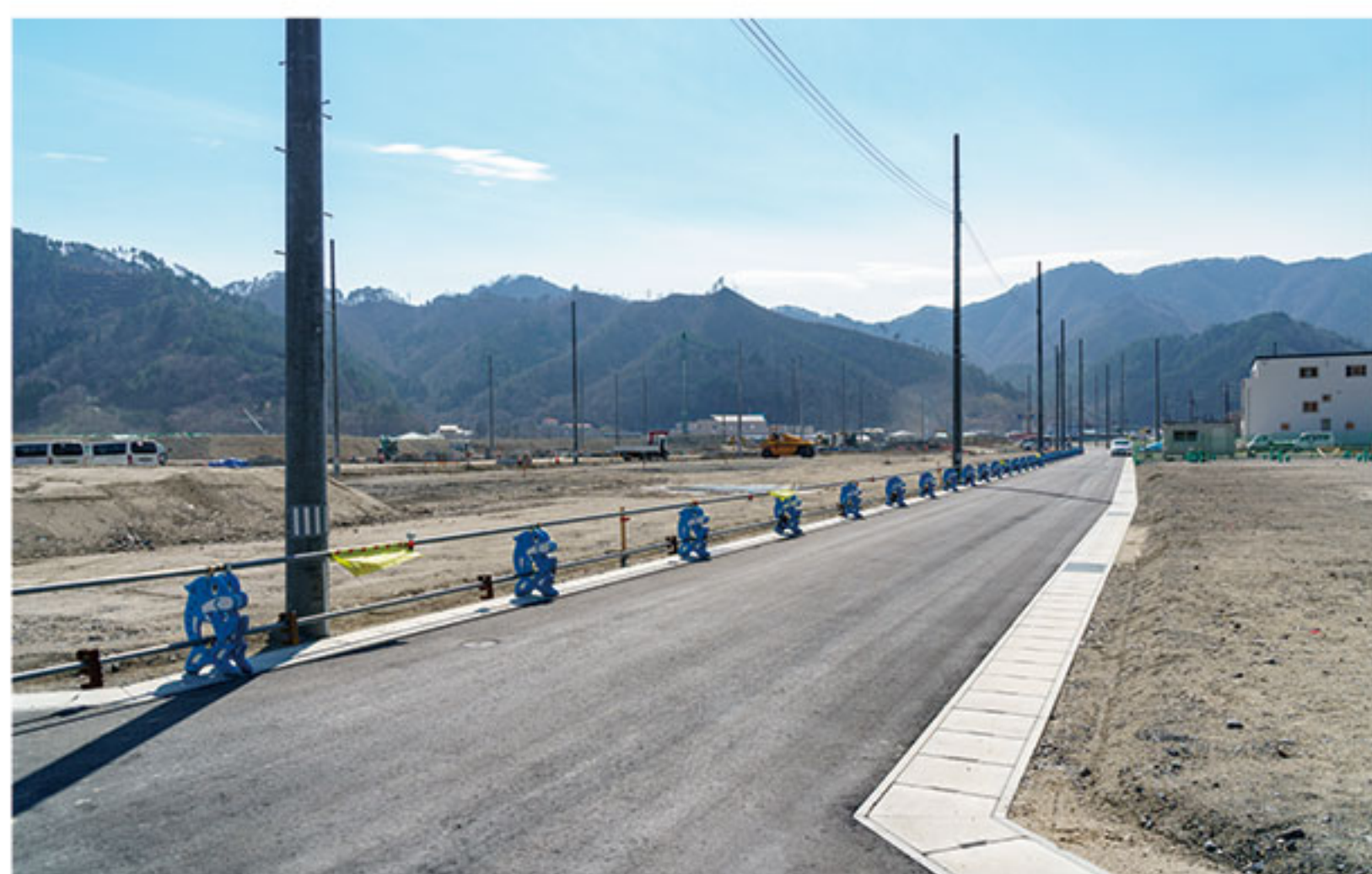
4月6日：県道から1ブロック南側の街区の様子。写真右側が県道沿いの街区。この道路が整備済みと整備中の境目がある事が分かる。
