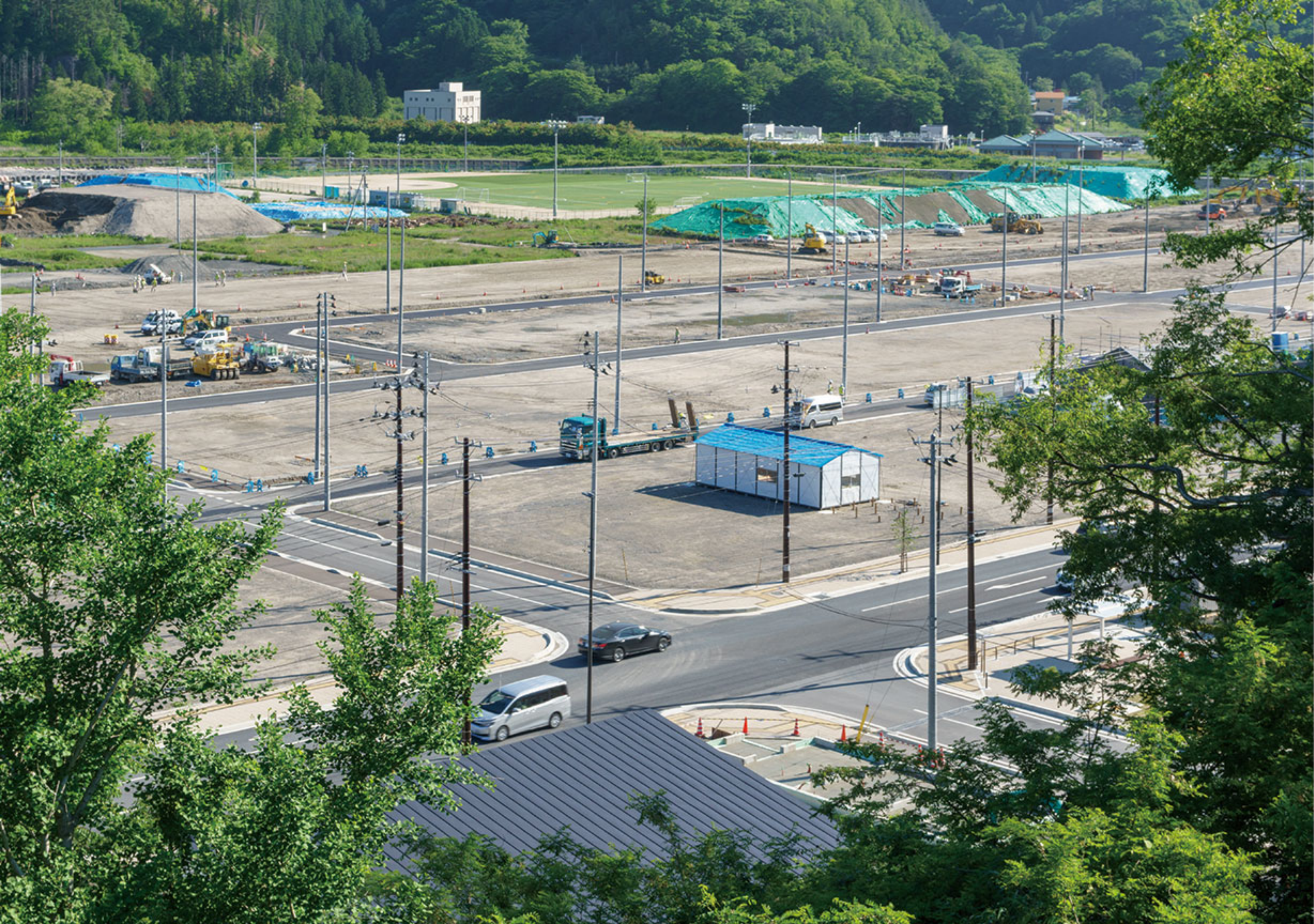
6月6日：上町の東側を高台から。13ページの写真と比べると、ほとんど整備が終わっていることがわかる。道路の舗装も完了し、電線の架設や杭の埋設などを残すのみとなった。
